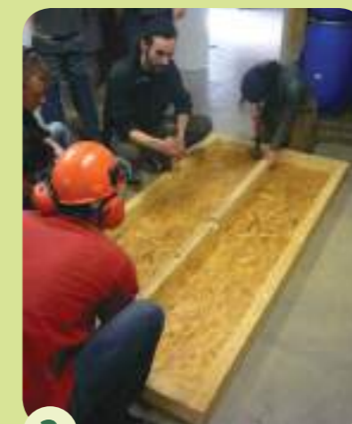
2 Ajout de chevrons pour renforcer la structure
