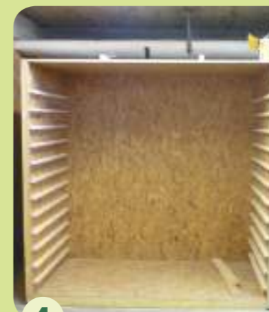
4 Fixation des tasseaux qui serviront de support aux claies
